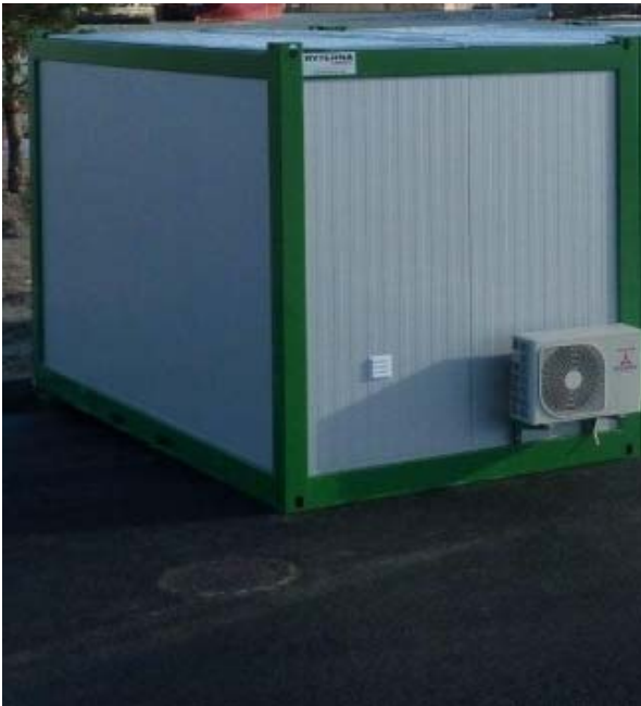
Figuur 46: Geprefabriceerd airco- gekoeld gebouw
